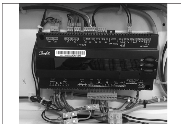
Figura 5: Cablaggio temporaneo
