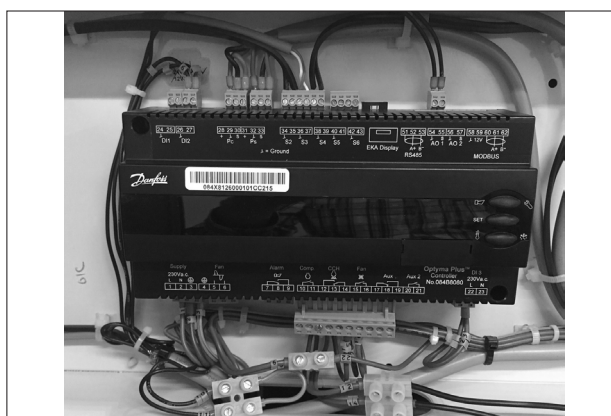
Rysunek 5: Okablowanie tymczasowe
