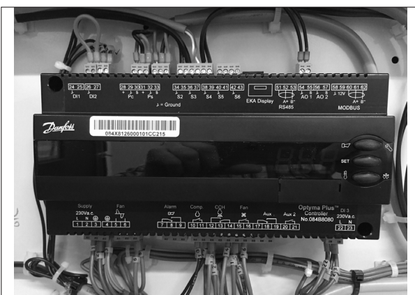
Figura 4: Cablaggio normale
