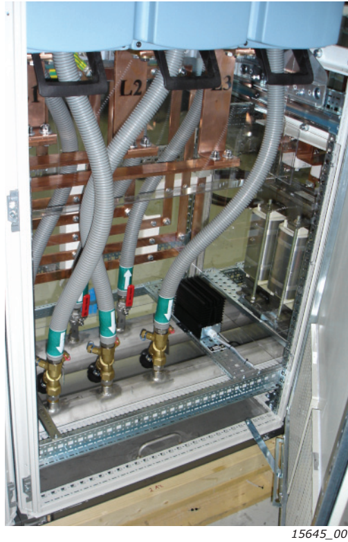
图 30. 供水软管的安装示例
