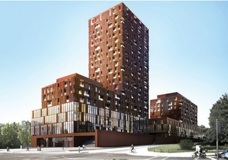
Situla-byggnaden, Ljubljana, Slovenien
