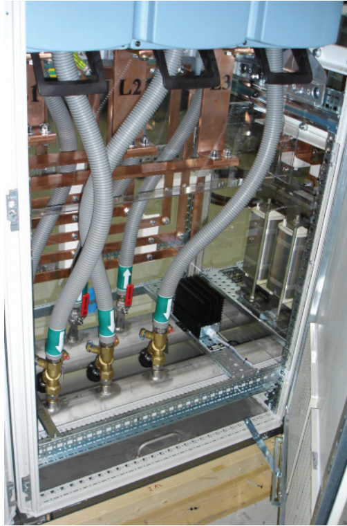
Abbildung 30. Beispiel für die Installation der Wasserschläuche
