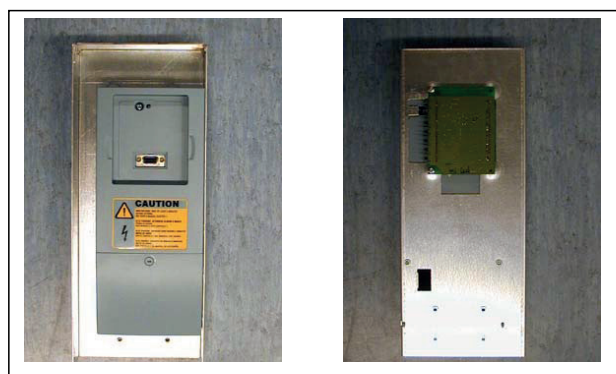
Figura 69. Unidad de control instalada en la caja de montaje; izquierda: delante; derecha: detrás
