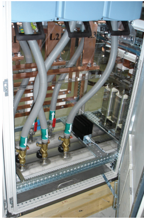
Figura 30. Ejemplo de instalación de tubos flexibles de agua
