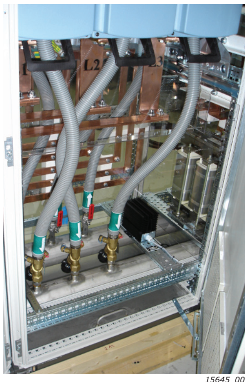
Figure 30. Exemple d'installation de flexibles d'eau
