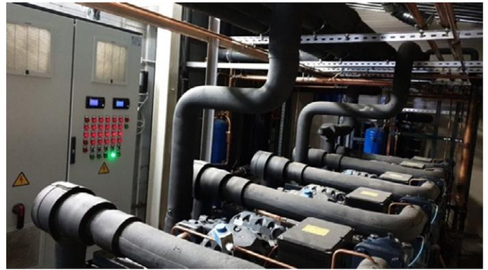
Формат Dark Store совмещает в себе как большие камеры хранения, так и холодильную мебель коммерческой серии. Современные системы автоматизации Danfoss помогают эффективно эксплуатировать все холодильное оборудование на объекте. Блок мониторинга AK-SM 850 объединяет контроллеры в единую сеть, поэтому контроль параметров и сервисное обслуживание можно осуществлять удаленно.
