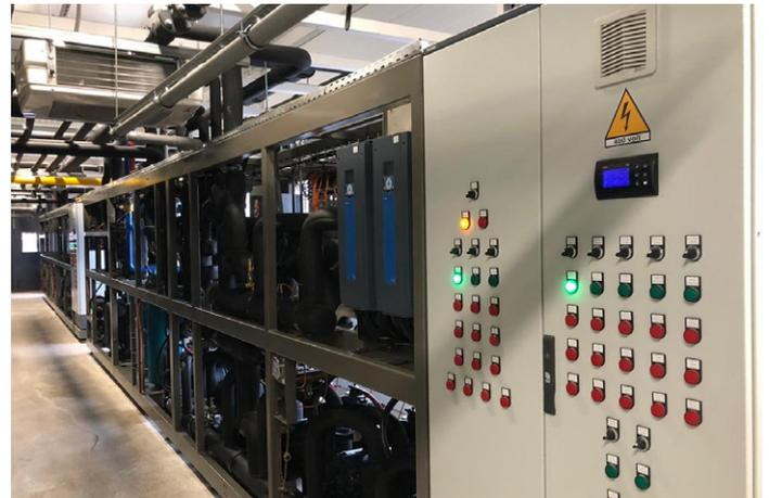
Лидирующие компрессоры каждого контура оборудованы частотными преобразователями. Они плавно регулируют производительность компрессоров, чтобы она четко соответствовала требуемой нагрузке. Это вносит значительный вклад в оптимизацию энергопотребления системы. Для среднетемпературного контура предусмотрено два компрессора с частотными приводами.
