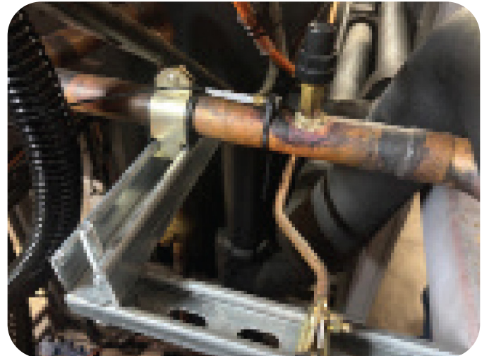
↑ La Figura 7 muestra el punto de medición de la vibración del cabezal de descarga LT (véase el Gráfico 4).
