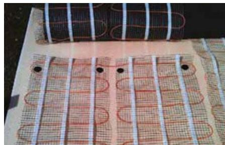
4. Når sidelinjen nås, fastgjøres varmematten for hver 30. cm med de spesielle karbonspikrene.
