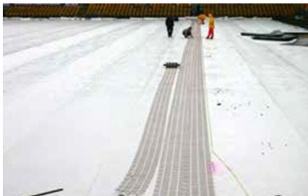
1. Rull ut varmematten og finn midten.
