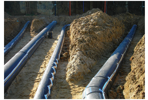
Rørledning i Strzelce Opolskie, Polen
