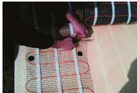
2. I midten av varmematten skjæres nettet - ikke kabelen.
