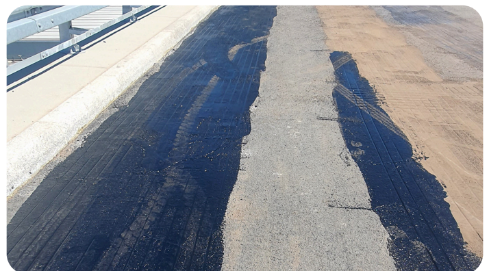
Abb. 1. DEVIasphalt™-Heizkabel unter der ersten Schicht Straßenasphalt, mit einer Handwalze verdichtet
