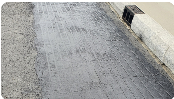
Abb. 1. DEVIasphalt™-Heizkabel unter der ersten Schicht Straßenasphalt, mit einer Handwalze verdichtet
