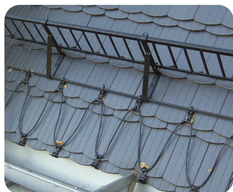
Краї даху та водостічні жолоби, обладнані системою нагріву.
