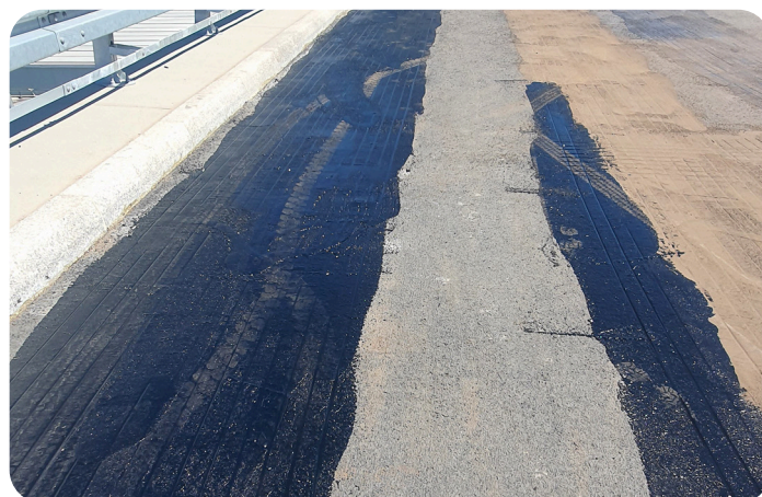
Fig. 1. DEVLasphalt™ varmekabel under det første laget med veiasfalt, valset med en håndvals
