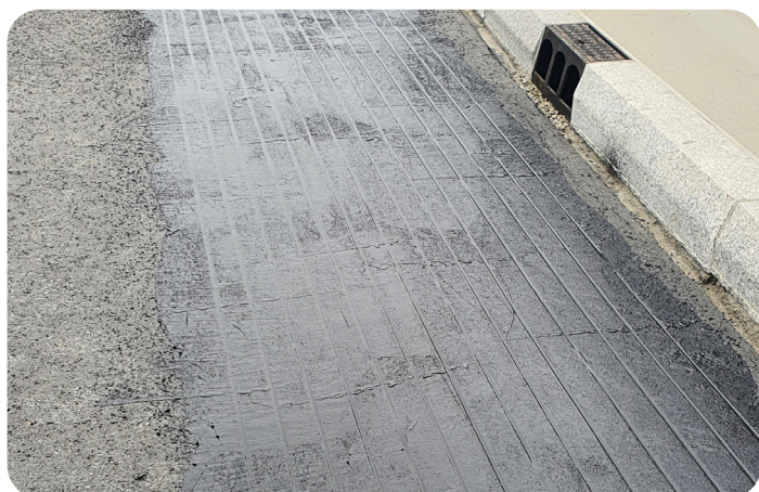
Fig. 1. DEVLasphalt™ varmekabel under det første laget med veiasfalt, valset med en håndvals
