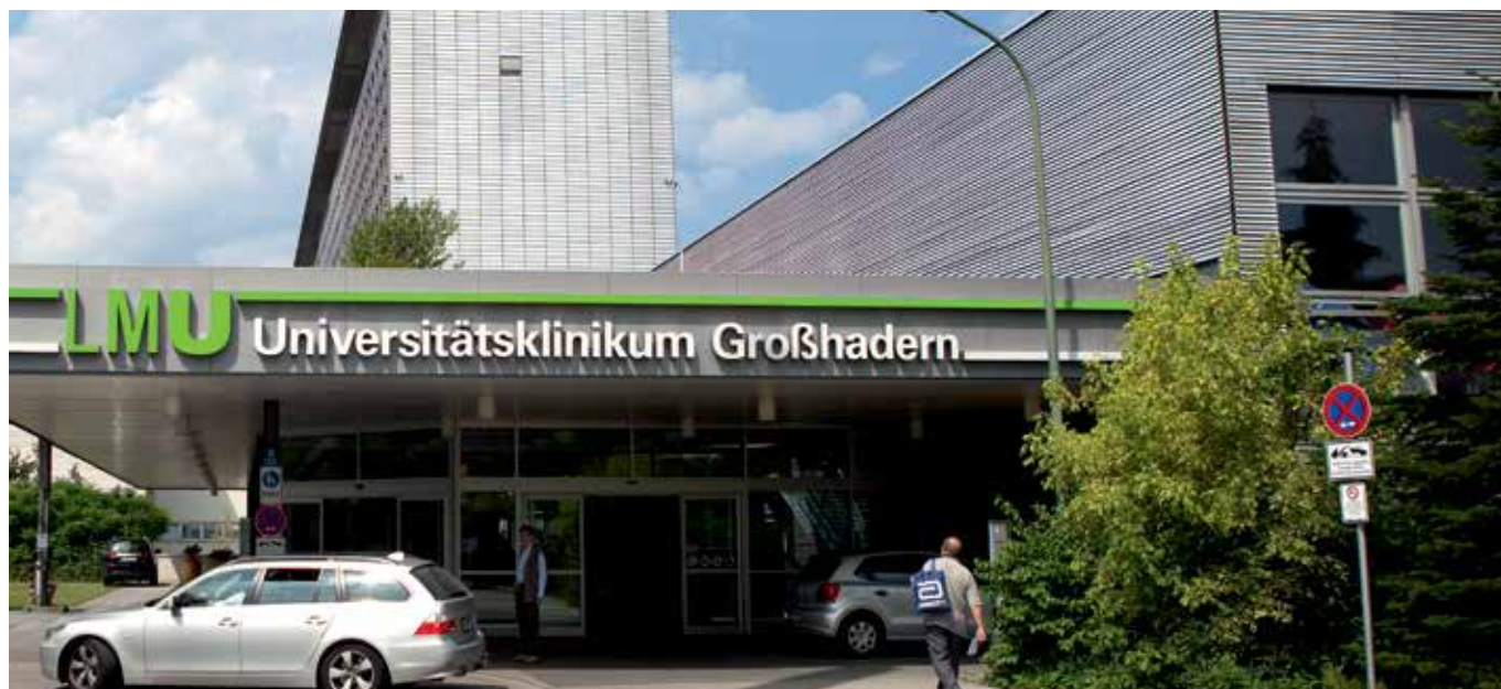
Мюнхен, Германия – Нежилищна сграда със система за отопление и производство на битова гореща вода.
