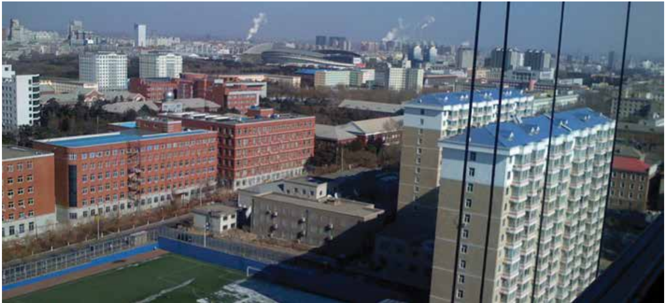
Changchun, Chine : bâtiments collectifs et commerciaux raccordés au chauffage urbain.
