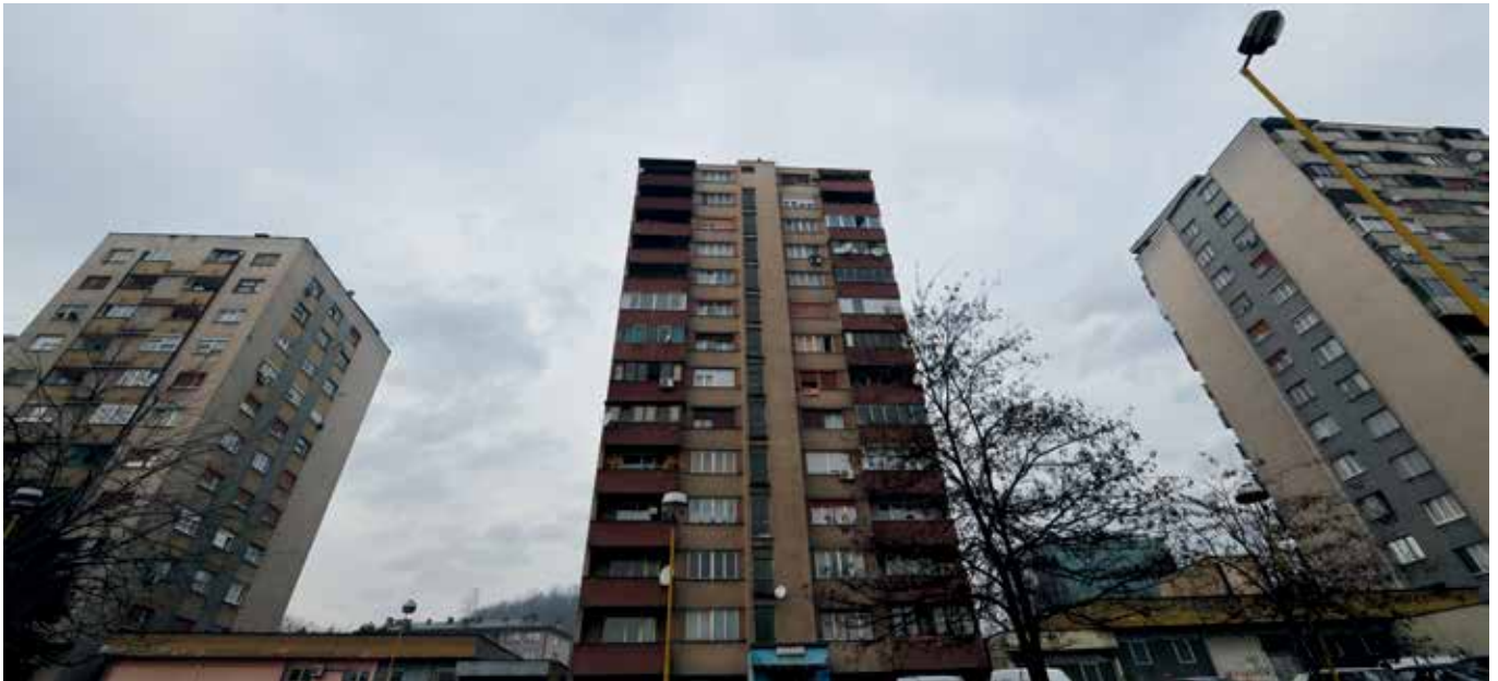
Tuzla (Bosnien & Herzegowina) – Mehrfamilienhäuser mit Fernwärme-Applikation
