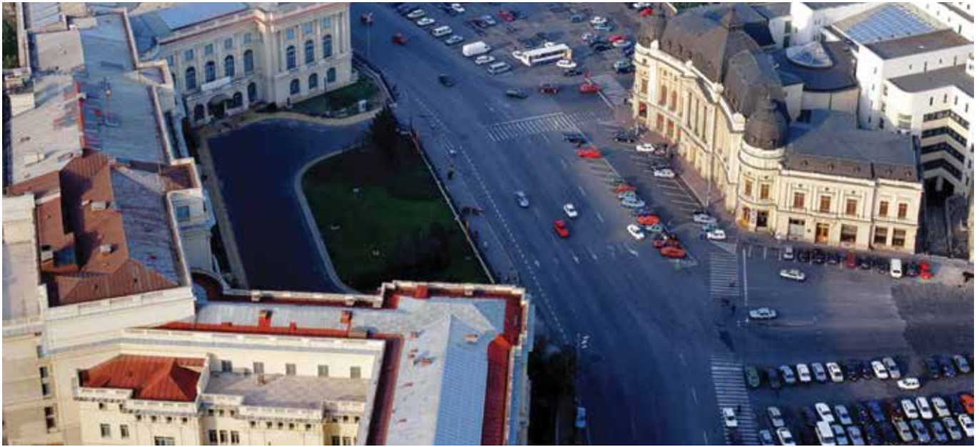
Bukarest (Rumänien) – Mehrfamilienhäuser und Gewerbebauten mit Fernwärmeversorgung
