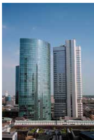
Ubicazione: Francoforte, Germania Progetto: Silver Tower Applicazione: AB-QM per riscaldamento e raffreddamento
