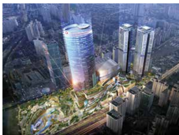
Ubicazione: Seoul, Corea del Sud Progetto: città e centro commerciale D-Cube Applicazione: AB-QM per riscaldamento e raffreddamento
