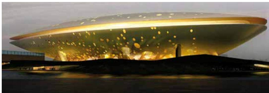
Ubicazione: Shanghai, Cina Progetto: World Expo Performance Center Applicazione: AB-QM per riscaldamento e raffreddamento
