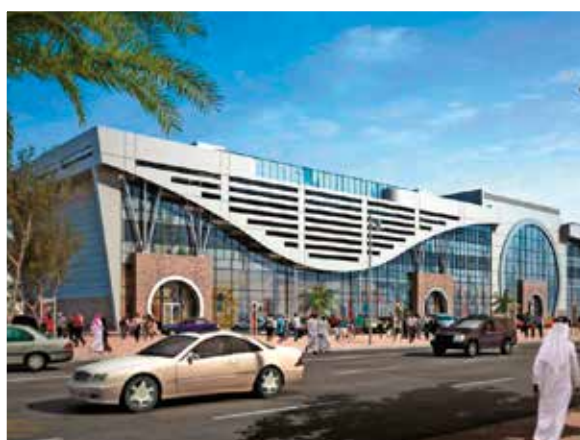
Locație: Doha, Qatar Project: Barwa Commercial Avenue Aplicație: AB-QM pentru răcire
