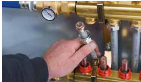
**Рис. 1.** Наденьте гайку компрессионного фитинга на трубу, вставьте фитинг в трубу до упора.
