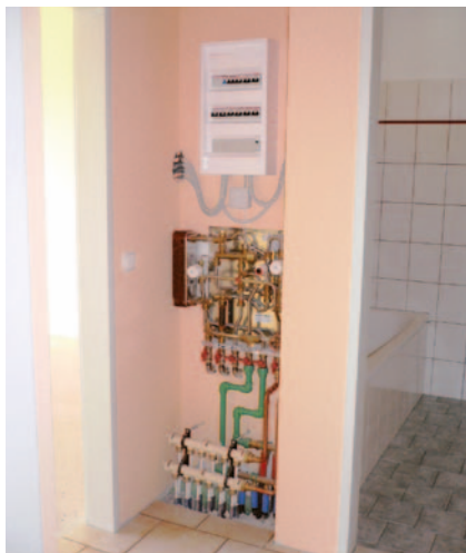
Lakás-hőközpont aknatérbe vagy szekrénybe építve.
