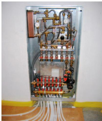
Süllyesztett beépítésű lakás-hőközpont padlófűtés osztó-gyűjtő egységgel.
