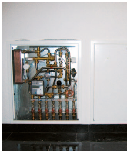
Falmélyedésbe süllyesztett beépítés.
