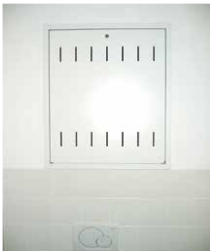
Stanovanjska postaja s pokrovom, montaža podometno v jašek v kopalnici.
