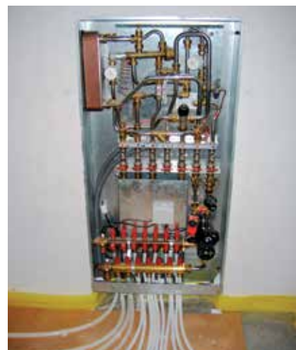
Podometna montaža stanovanjske postaje z distribucijsko enoto za talno ogrevanje.
