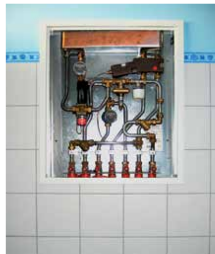
Stanovanjska postaja, podometna montaža v kopalnici.
