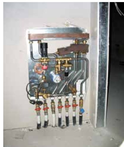
Nadometna montaža stanovanjske postaje.
