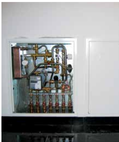
Podometna montaža v kuhinji.
