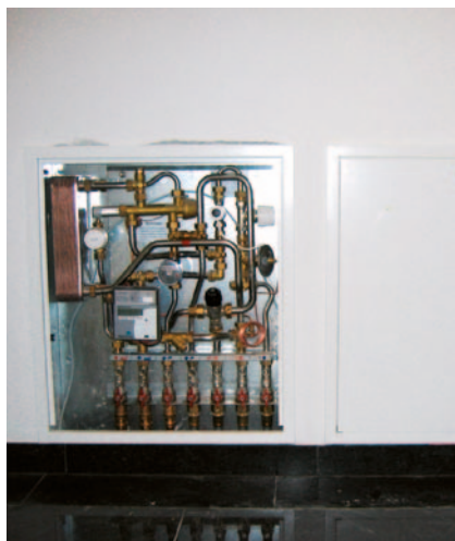
Zapustená montáž v podlahe a v kuchyni
