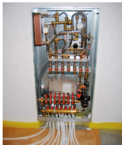
Zapustená montáž bytovej stanice s rozdeľovačom podlahového vykurovania
