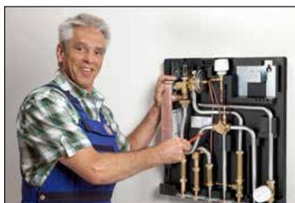
Les systèmes de chauffage avec modules d'appartements EvoFlat™ peuvent être exploités avec l'ensemble des sources d'énergie disponibles. Si le système est correctement planifié, il ne lui faudra que trois des cinq colonnes d'alimentation habituelles et le besoin en test de détection des légionelles sera supprimé. Ces modules d'appartements disposent également d'une fonction d'équilibrage automatique intégrée qui assure une distribution de chauffage dans
