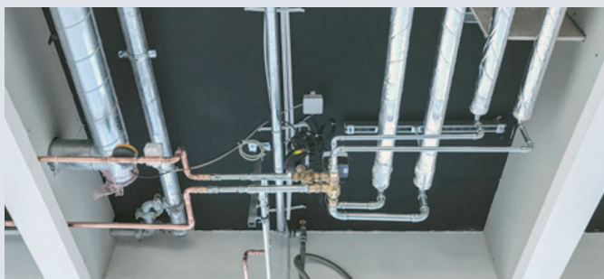
Вузол під'єднання орендаря з використанням АВ-QM, NovoCon та 6-ти ходовим перемикальним клапаном
