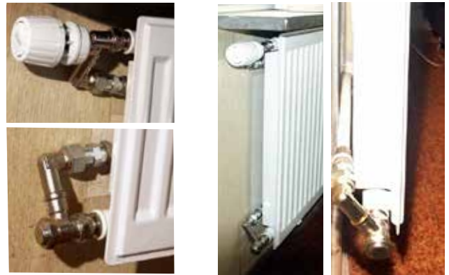
Med alupexrör och nya RadiCal är det enkelt koppla ihop bakom radiatoren vilket också är mycket smidigt för montörerna.
