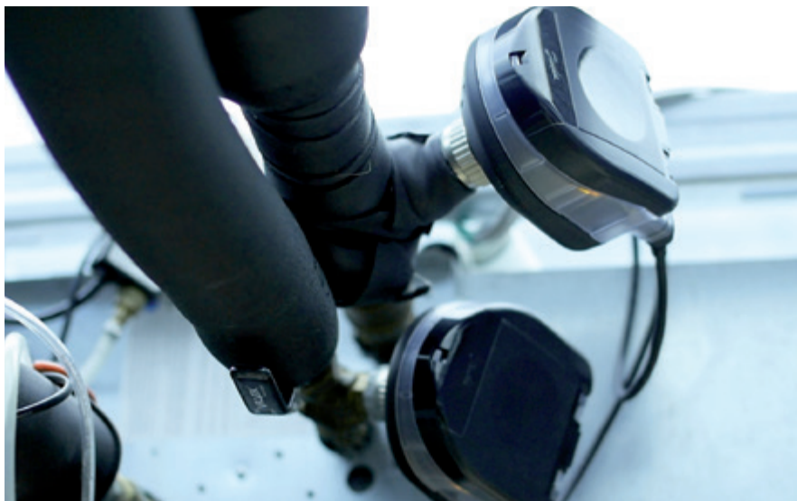
Napęd NovoCon® w połączeniu z zaworem AB-QM
