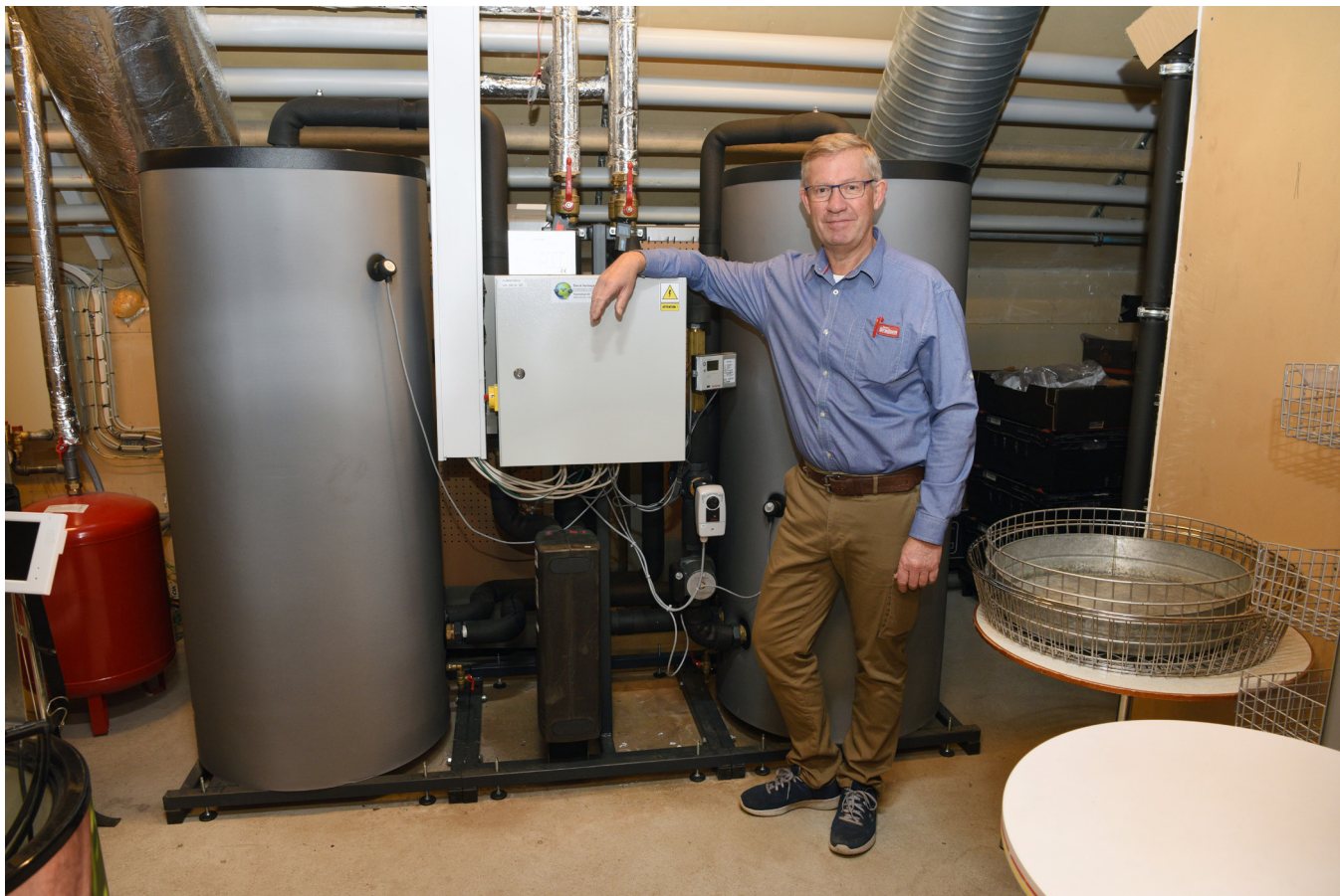
Det kører bare, siger Hans Jørgen Andersen. Den nye varmegenvindingsløsning fra Danfoss opvarmer 3400 m 2 og sørger også for masser af varmt vand til butikkens slagter og bager. Når der en bager og slagter i en brugs, er der et stort forbrug af varmt vand til rengøring. Det klarer overskudsvarmen fra kølediskene også.
