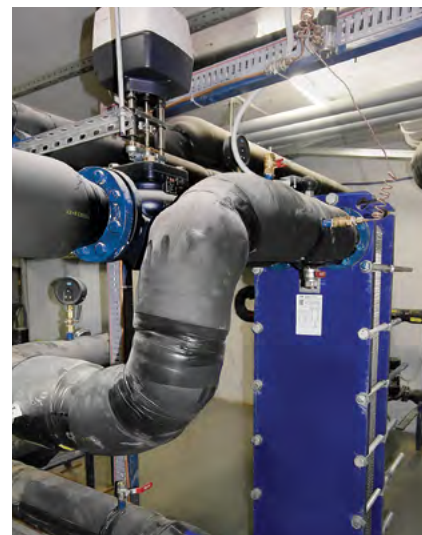
ПТО для системы вентиляции
