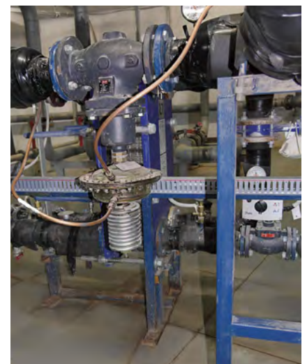
Регулятор перепуска типа AFPA/VFG 2 для ГВС
