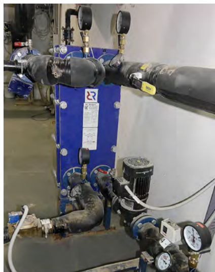
ПТО на контуре системы водяная петля
