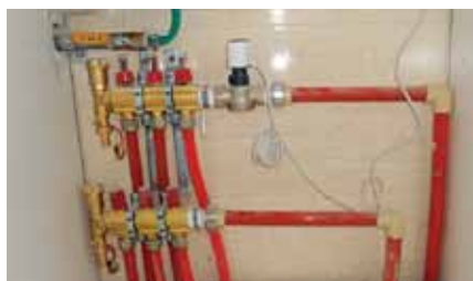
Rozdělovač/sběrač Danfoss s ventilem RA-G a pohonem TWA-A. Tato kombinace byla instalována v menších bytech, aby byla zajištěna centrální regulace teploty prostřednictvím termostatu CWD v hlavní obytné místnosti. Samostatné regulační prvky v místnostech byly instalovány ve větších bytech.
