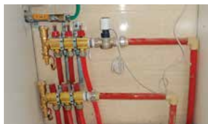
Danfoss kolektorius su RA-G vožtuvu ir TWA-A pavarą. Šie abu prietaisai buvo sumontuoti mažesniuose butuose, siekiant centralizuotai CWD termostatu, sumontuotu svetainėje, reguliuoti temperatūrą. Didesniuose butuose buvo sumontuoti individualūs kambario valdikliai.
