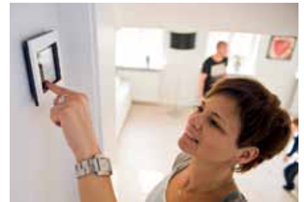
Heizungsregelung von zentraler Stelle aus
