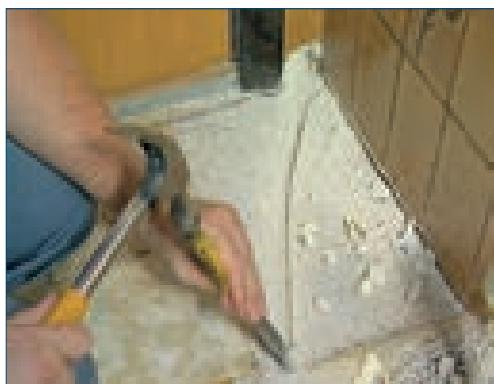
2. Штробление стяжки допускается на глубину не более 10 мм с последующим обязательным заполнением оставшихся пустот плиточной мастью.
