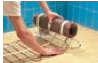
У противоположной стены или при обходе места установки стационарного оборудования сетку маты разрезают и мат поворачивают вокруг кабеля в нужном направлении.
