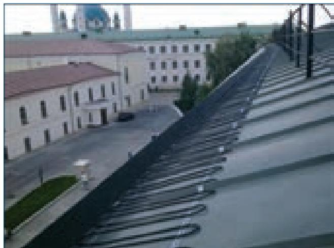
Крепление кабеля производят с помощью монтажной ленты **DEVIfast™** аналогично креплению в желобах.
