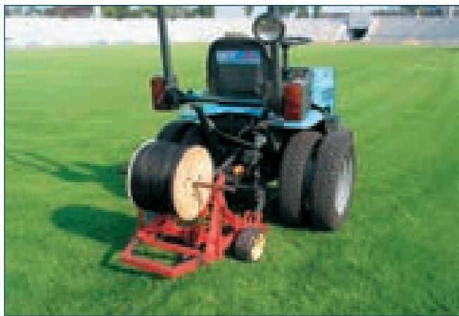
Расстояние между нитками кабеля зависит от его погонной мощности и установленной мощности на 1 м<sup>2</sup>. Эта величина лежит в пределах 20 - 40 см. Поверхность грунта практически не повреждается и готова к использованию спустя 10 - 15 дней после установки. Нагревательные кабели устанавливают на 20 - 30 см ниже поверхности, чтобы избежать их повреждения при использовании спортивных снарядов с острыми наконечниками и прочими инструментами технических служб.
