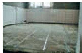
3. Разложить нагревательный кабель и закрепить на ленте с соблюдением шага укладки. Также на ленте закрепить датчик температуры пола в медной или гофрированной трубке (гофр – защита от сдавливания при заливке раствором) и подвести «холодные» выводы нагревательного кабеля и выводы датчика к месту установки терморегулятора.
