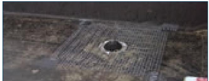
В случае, если водосточные трубы уходят в ливневую канализацию, сопровождающий обогрев необходим до точки промерзания грунта в данной местности. Также может потребоваться дополнительный обогрев ливневых колодцев и утепление их крышечек.
