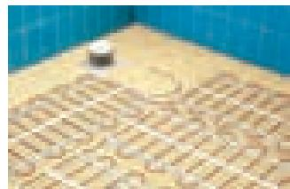
На разложенный мат **DEVI** наносят плиточный клей (плиточную мастику) и укладывают плитку.
