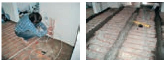
Трубка термодатчика ( $\varnothing$  9 - 16 мм) должна быть заглущена со стороны датчика для предотвращения попадания внутрь раствора при заливке стяжки. Противоположный конец трубы выводят в монтажную коробку, в которой затем будет смонтирован терморегулятор. Чтобы обеспечить свободное перемещение термодатчика в трубке (возможность замены в процессе эксплуатации), рекомендуем при переходе от стены к полу выполнять два больших радиуса изгиба трубки в двух плоскостях.
