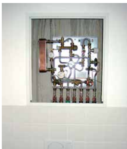
Podometna montaža stanovanjske postaje v jašek v kopalnici.
