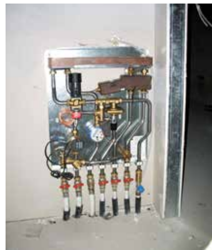
Nadometna montaža stanovanjske postaje.
