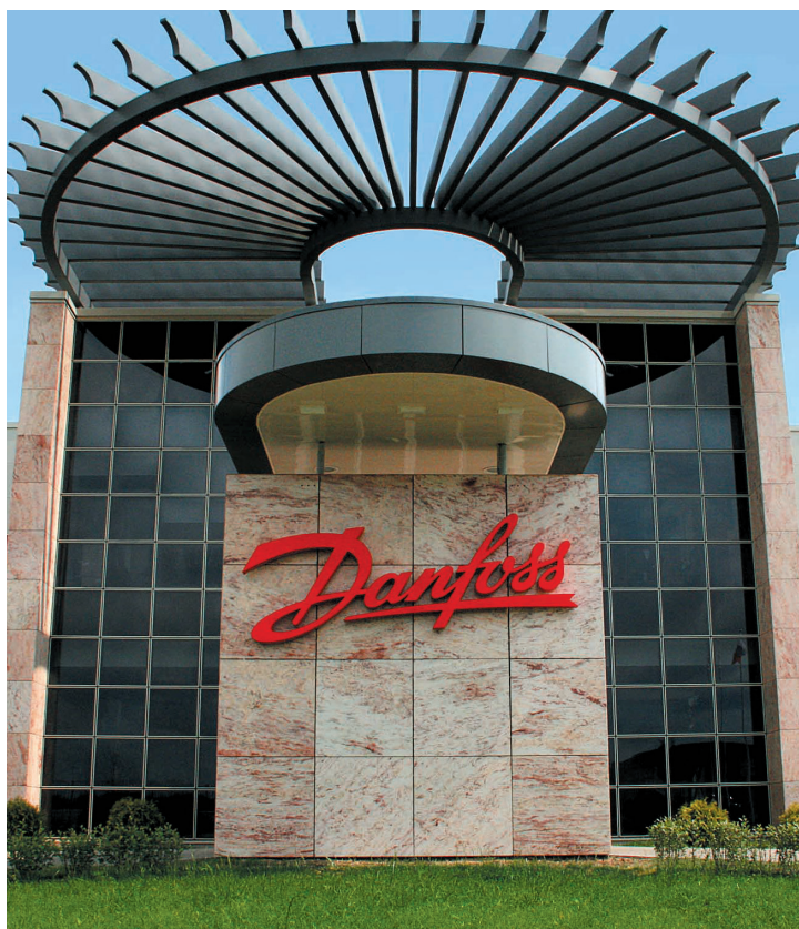
Рис. 1. Здание ООО «Данфосс»
