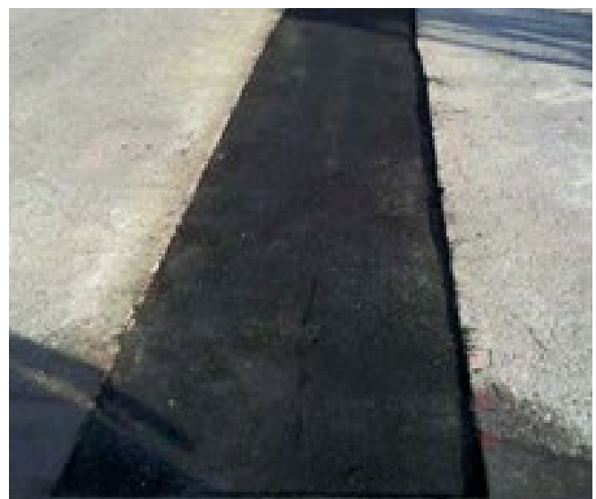
Рис. 2 – Кабелі із захисним бетонним покриттям перед подальшим улаштуванням асфальту.
