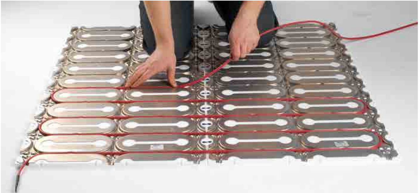
Fig. 20. Montagemetode for varmekabel i DEVIcell™
