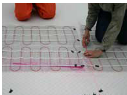
Udlægning af DEVIheat™ 90S-måtte
