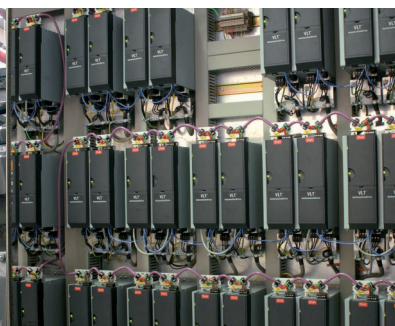
Le VLT® AutomationDrive FC 302 convient aux installations centralisées.
