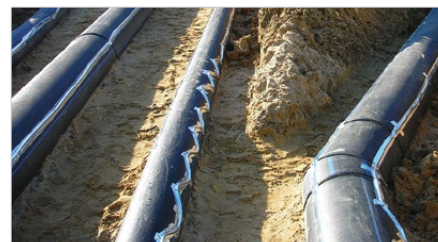
Frostsikring rørstrækning i Strzelce Opolskie, Polen
