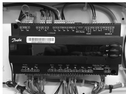
Rysunek 3: Normalne okablowanie
