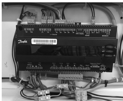
Rysunek 4: Okablowanie tymczasowe
