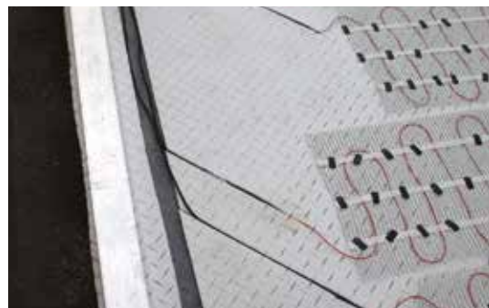
6. Kutt en rille i støtabsorberingen, men ikke i dreneringsmatten. Tilpass kaldendene, og før dem til nærmeste kabelbrønn.
