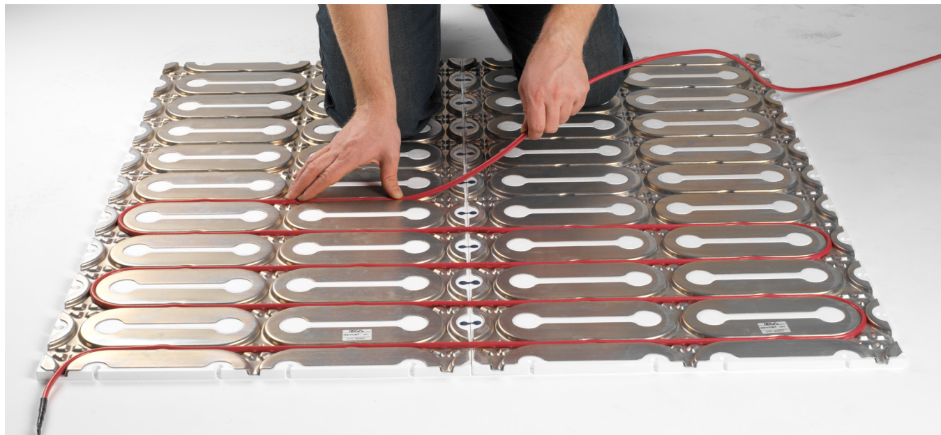
Fig. 20. Metodă montare cablu de încălzire în panoul DEVicell™
