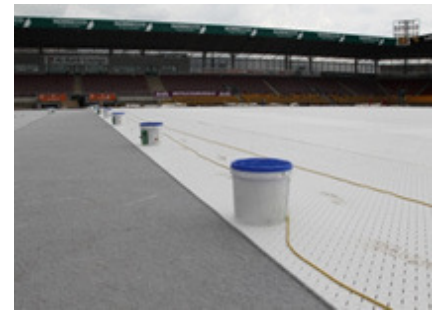
Läggning av stötkuddar
