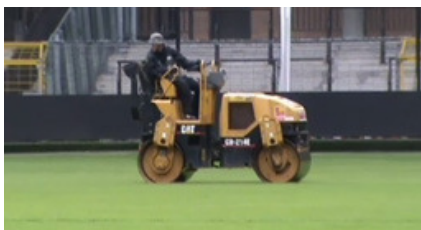
Efter plogprepareringen sås gräset och jorden återställs med hjälp av en vägvält.
