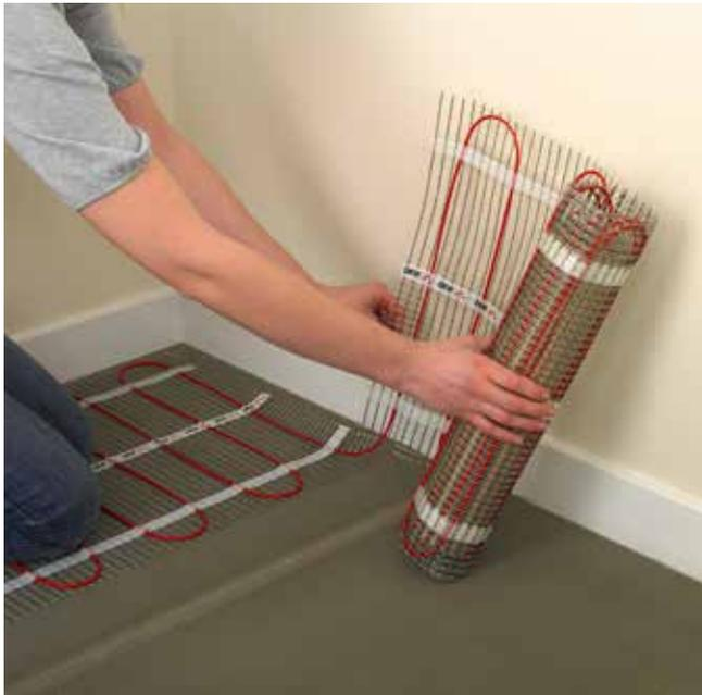
**Achtung:** beim Aufschneiden oder Umklappen der Heizmatte wird immer vom Heizleiter in Richtung Netz geschnitten. Heizelemente bzw. Heizleitungen dürfen sich nie überlappen oder kreuzen. Die Mindestabstände zwischen den Heizleitungen richten sich nach den Angaben der Hersteller. (siehe Seite 25 Prüfprotokoll)
