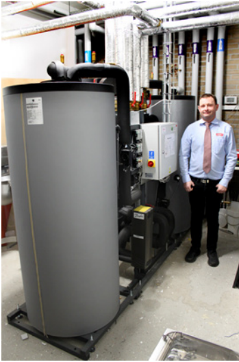
Morten ved Varmegjenvinningsenheten (HRU).
