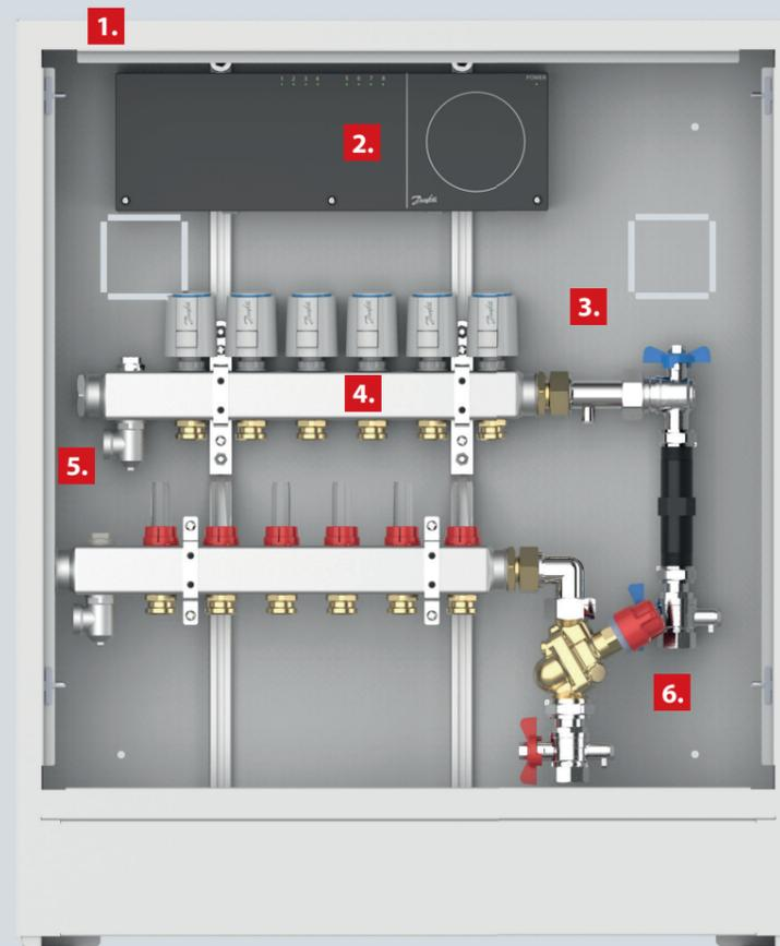
1. Armoire encastrée avec pieds réglables, découpes pour les raccordements de chauffage et portes discrètes en RAL9016
