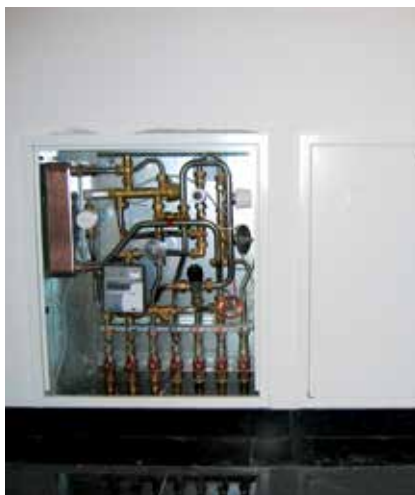
Podometna montaža v kuhinji.
