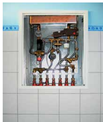
Stanovanjska postaja, podometna montaža v kopalnici.
