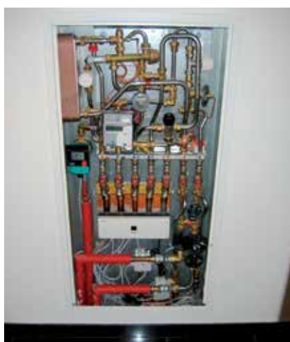
Podometna montaža stanovanjske postaje z distribucijsko enoto za talno ogrevanje in regulatorjem.
