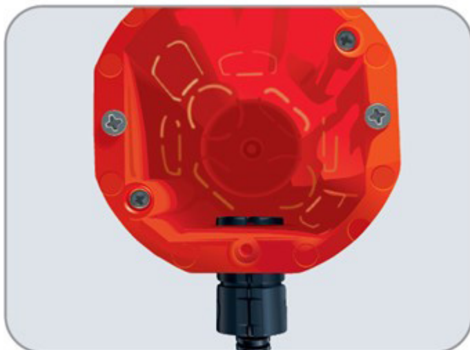
Foto 5 – Flexpipe mit Übergang eingebaut in der UP-Dose
