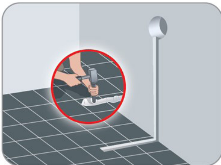
Foto 1 – kanaal in vloer en wand met gat voor schakelkast
