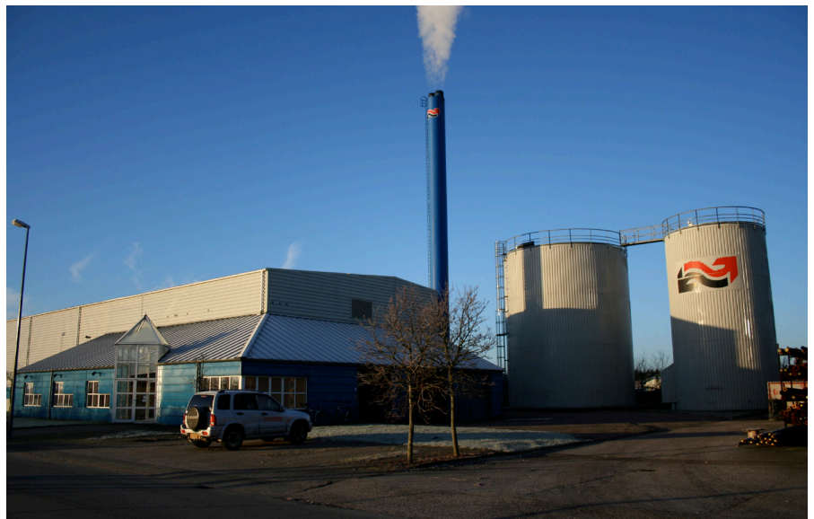
Auning Varmeværk på Djursland.
