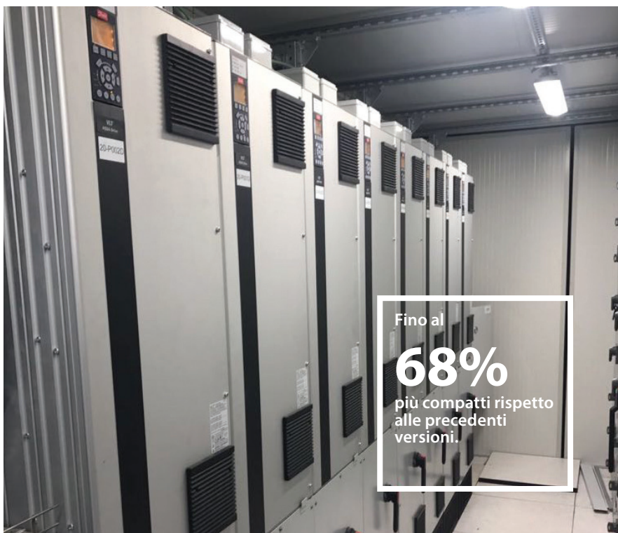
Convertitori di frequenza VLT AQUA Drive in frame D da 200 kW, estremamente compatti. Componente fondamentale per minimizzare il consumo energetico.
